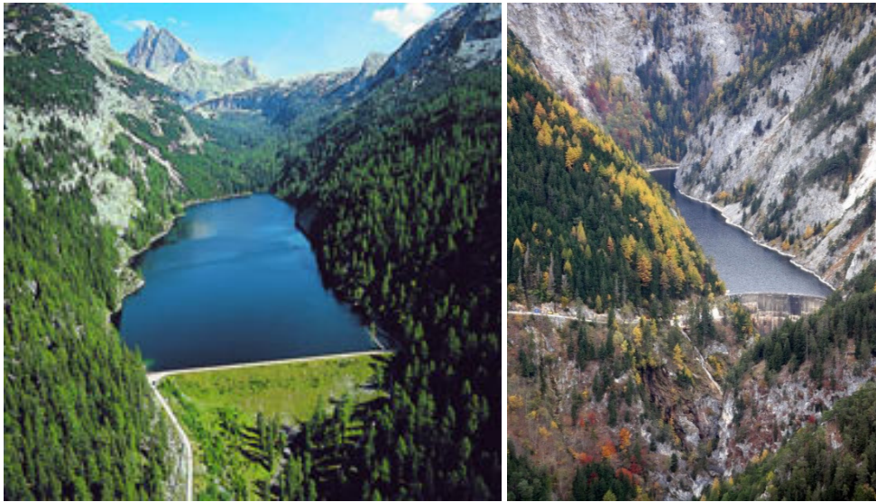
Fig. 6: Left: Diessbach Reservoir (Steinernes Meer/Salzburg) ( www.salzburg-ag.at/erzeugung/unsere-kraftwerke/wasserkraftwerk-diebach-2588/ ). Right: aerial view of Salza Barrage (Dachstein Massif/Styria) ( www.enstalwiki.at/wiki/index.php/Datei:Salza Stausee.jpg )
